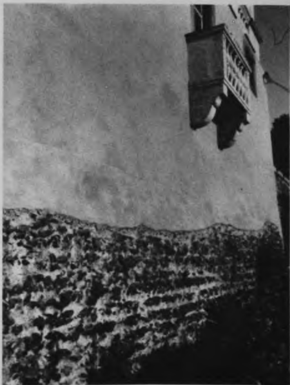
1. La vasca da bagno marmorea nel giardino di Villa Lante. 2. Villa Lante, particolare della facciata est, tratto di muro in opus concretum .
