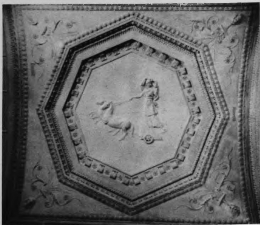
Villa Lante, loggia, rilievo IV : 1.
