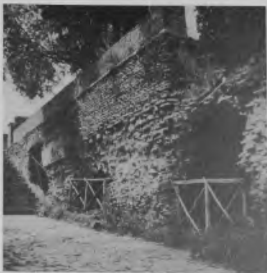
Fig. 7. Parte centrale dell'ala SO (stanze 9—11)
