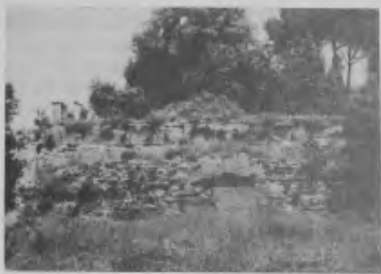
Fig. 8. Estremità NO dell'ala SO (in corrispondenza delle stanze 12—18). La parete esterna qui visibile era in origine la parete NE, o parete di fondo, delle stanze B2—B5. La parte superiore della parete apparteneva alle stanze del piano superiore, ora scomparse.
