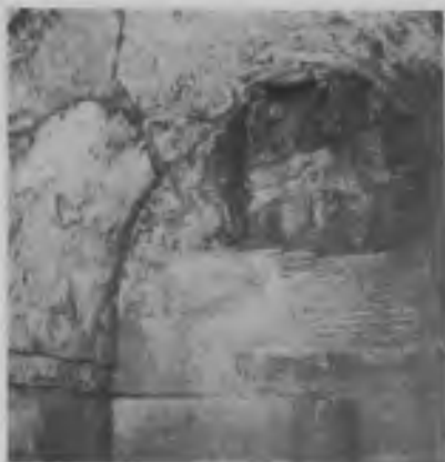
Fig. 14. Parete NE della stanza 4 e finestra murata
