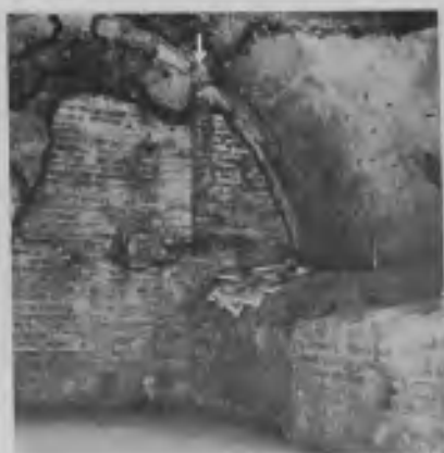
Fig. 23. Stanza 7. A destra, il muro di sostegno; sul fondo, la finestra murata
